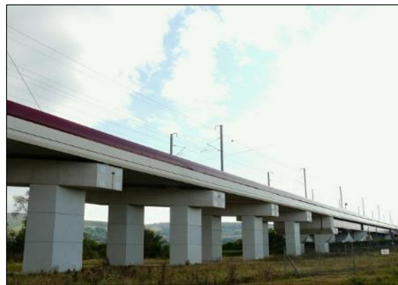
27. ábra. Mosel csatorna viadukt (2005)
