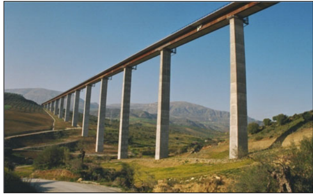
21. ábra Arroyo las Piedras (2005) viadukt Cordoba–Malaga
