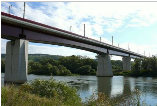
26. ábra. Moselle viadukt (2005)
