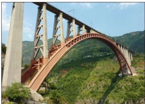
28. ábra. Beipanjiang vasúti híd (2001)
