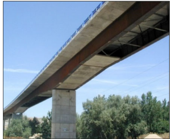
23. ábra Jarama híd, Madrid (2001)
