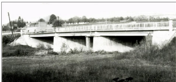
13. ábra A szalonnai Bódva-híd
