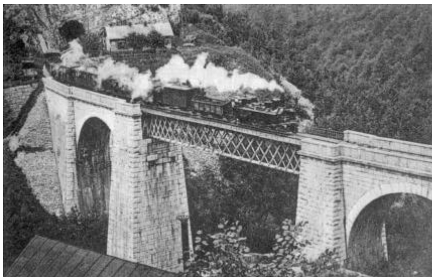
55. ábra Az arainai viadukt (Schluchst viadukt)
