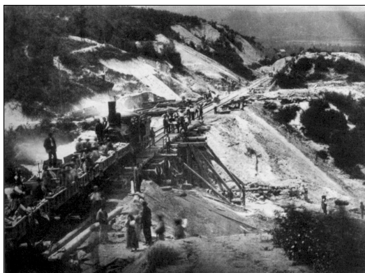
7. ábra A Piski-Petrozsény szárnyvonal pályája építés közben
