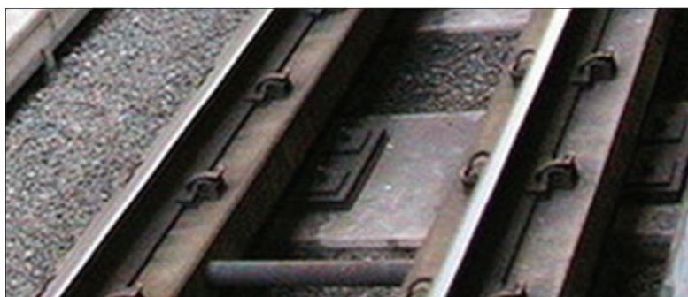
2. ábra: Hosszaljas pályaszerkezet
