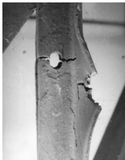
8. ábra Egy függőleges rúd szakadása a szögecslyuk környezetében
