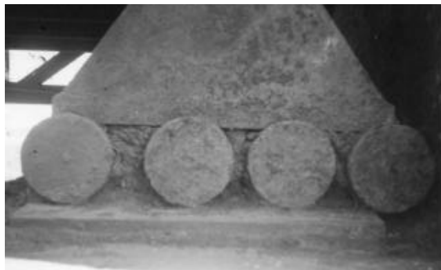
12. ábra Meghibásodott saruk; az alsó saruk elmozdultak és nincsenek normális helyzetben, a mozgó saruk elmozdultak
