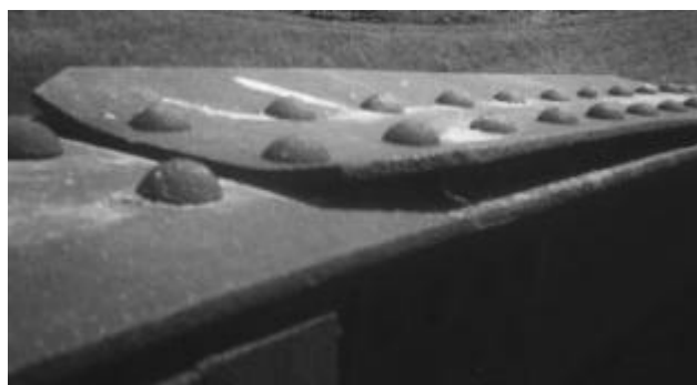
14. ábra Hevederes kapcsolat; a heveder erősen deformálódott
