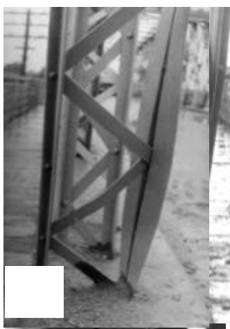
A felső szélrács tönkremenetele ütközés következtében
