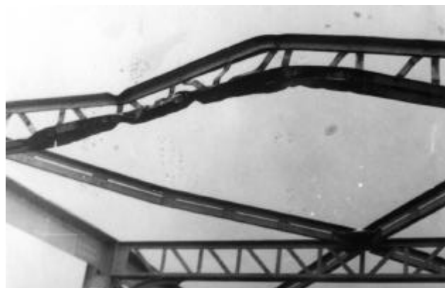
A felső szélrács tönkremenetele ütközés következtében
