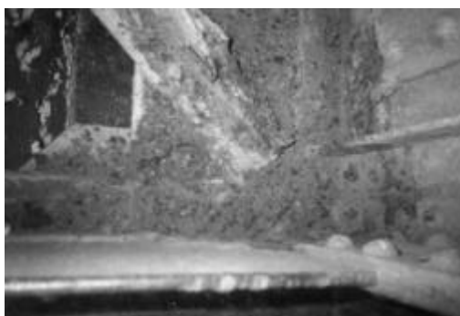
13. ábra Korrózió által tönkrement csomópont
