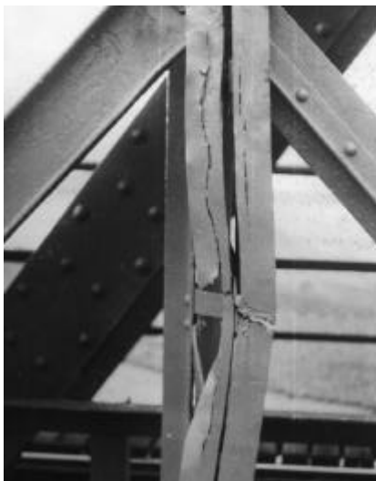
7. ábra Ütközés okozta rideg törés egy előregedett acéltartón
