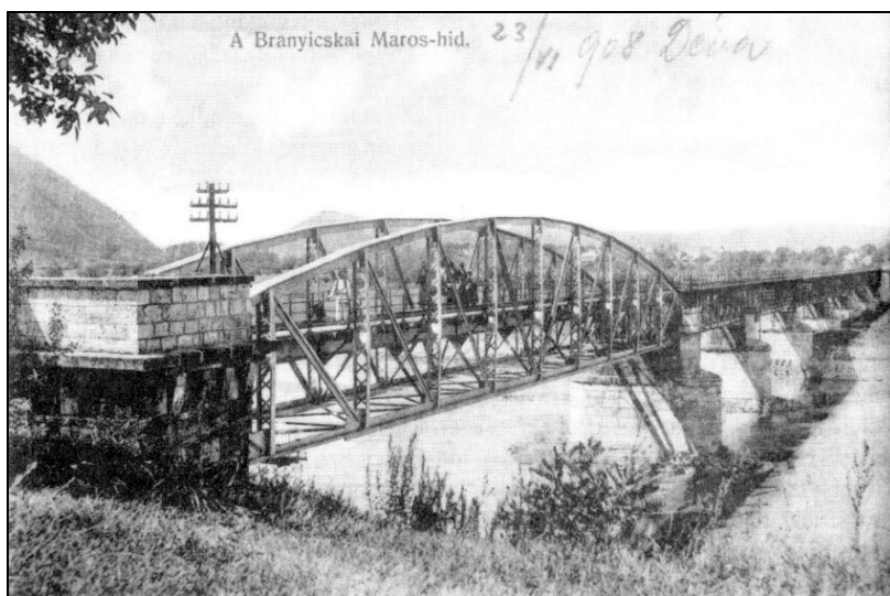
4. ábra A branyicskai Maros-híd vasszerkezetre átépített része
