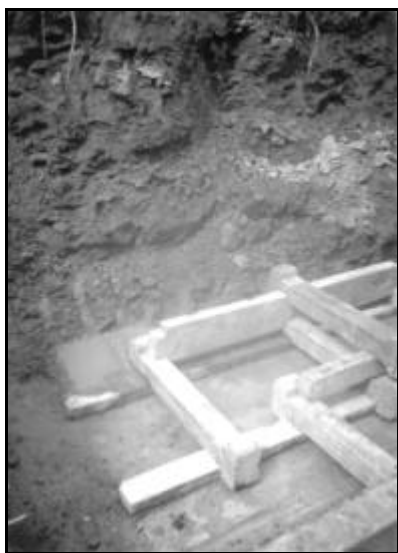
31. ábra A rétegvíz „befogásának” elokészítése a támszerkezet baloldali részén
