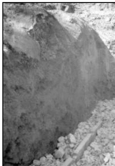
35. ábra A szárítóborda természetes kővel történő kitértése a föld felületéig
