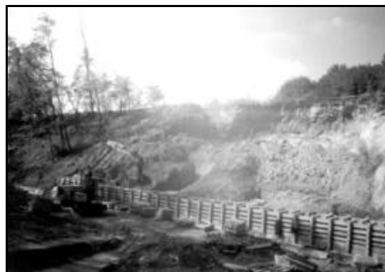
36. ábra A támszerkezet a rézsukárosodás hosszában, szerelés közben
