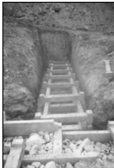
34. ábra A szárítóborda csatlakozása a támasztószervezethez, szerelés közben
